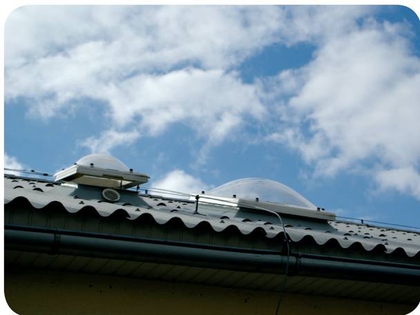
montáž světlíku ve vlnité střešní krytině
