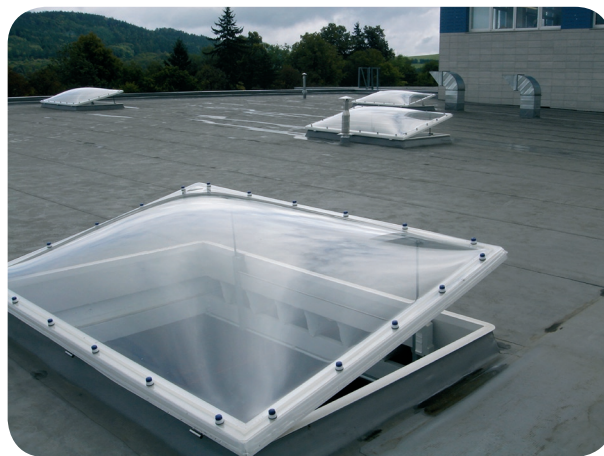
montáž světlíku s napojením na hydroizolační fólii
