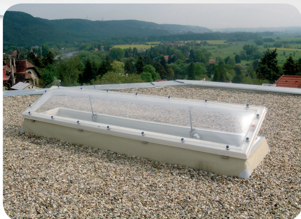
montáž světlíku v kačírku
